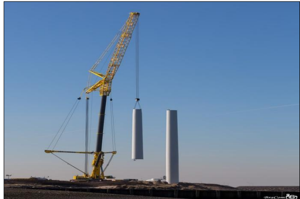
Figuur 12 : Bouw mast windturbine
