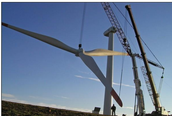
Figuur 13 : Plaatsing hub met wieken aan de gondel van de windturbine
