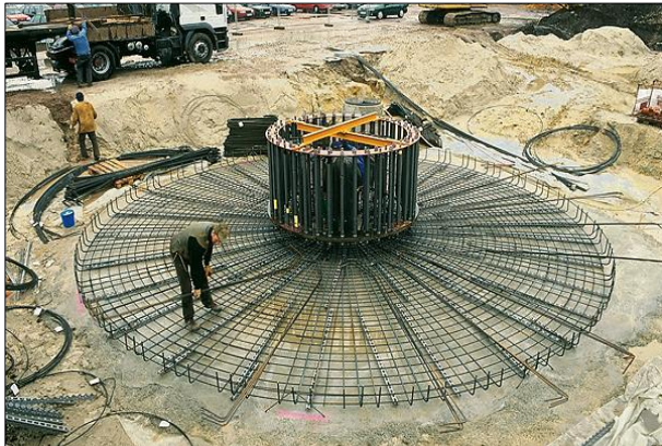
Figuur 11 : Fundering windturbine
